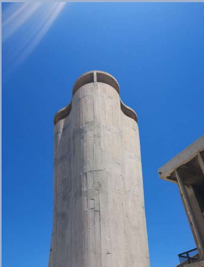
Vue depuis le toit de la Cité Radieuse (1947) ©Milena Krastev-McKinnon
